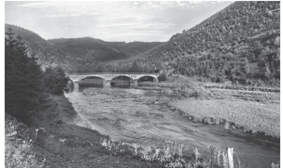
Historische Ansicht der Neidenbergaer Brücke. Das Bauwerk ist unzerstört im Stausee untergegangen, allerdings liegt der höchste Punkt, die Fahrbahn, meist bei 43 m Tiefe. (PHOTO-KÖNIG BAD LOBENSTEIN)
